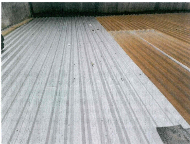
Imagem 03 – Substituição de telhas metálicas termoacústicas
